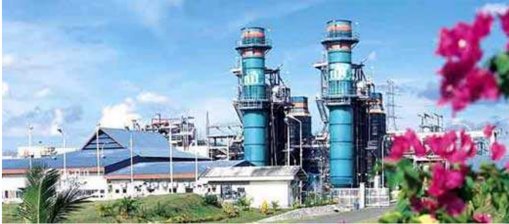
Figura 2. 8 Exemplo de Caldeira de recuperação da Alstom Power na Indonésia. Fonte: Site da Alstom Power.
