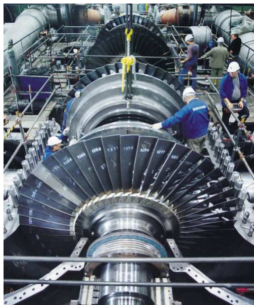
Figura 2. 9 – Montagem de uma turbina a vapor da Siemens, Alemanha. Fonte: Site da Energy Industries Council (EIC).
